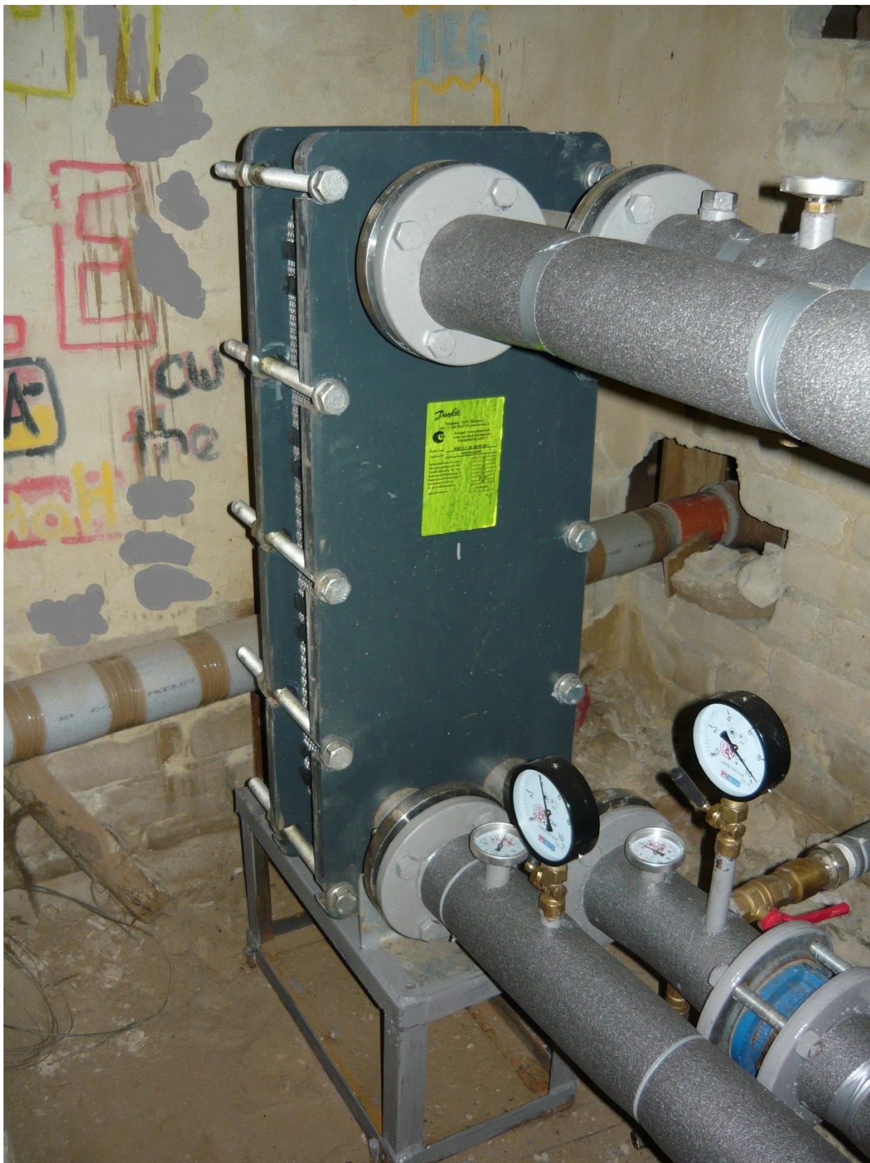
Полная замена теплового узла по ул. Мира, 425
