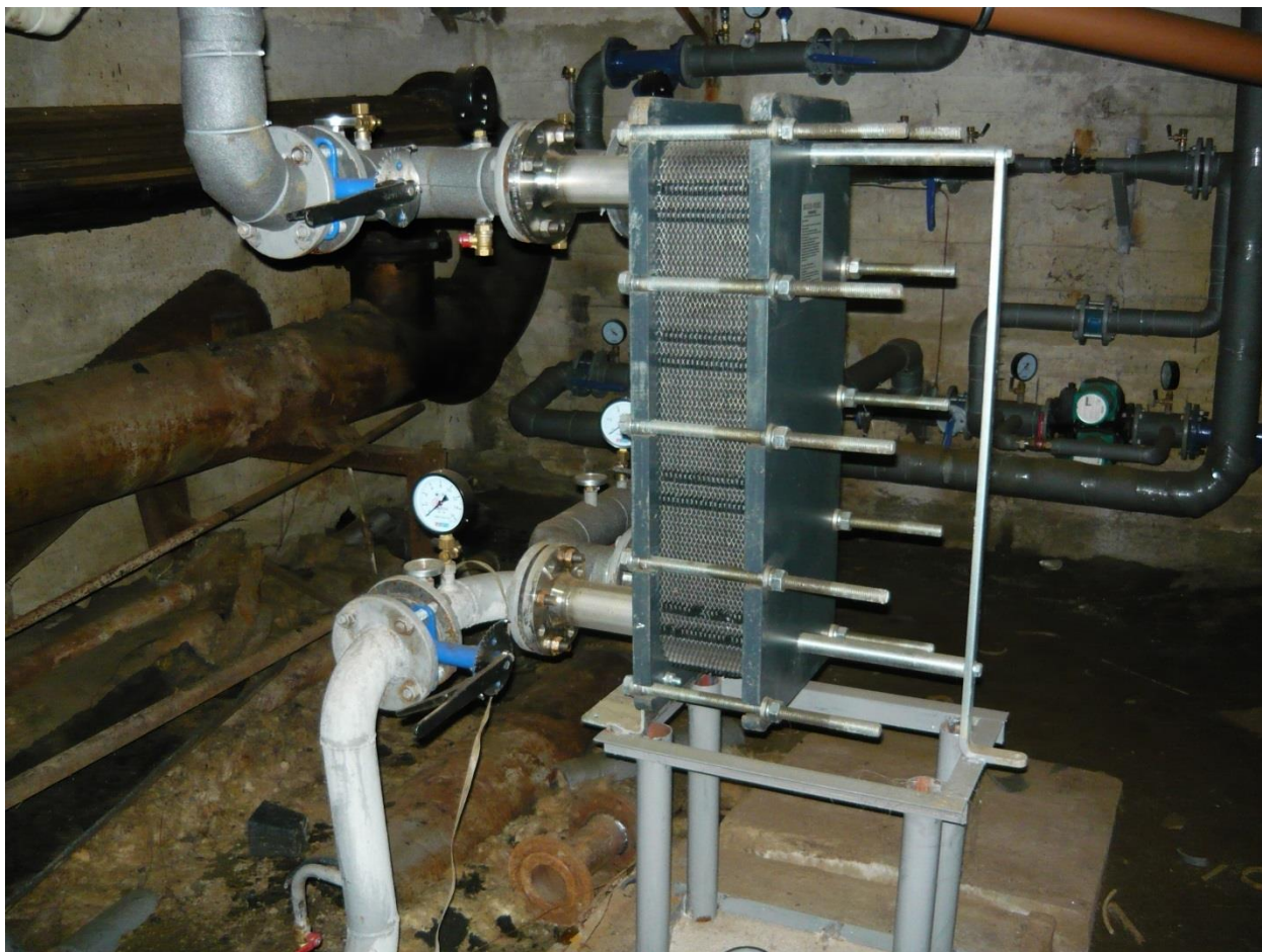
Полная замена теплового узла по ул. Доваторцев, 43/2
